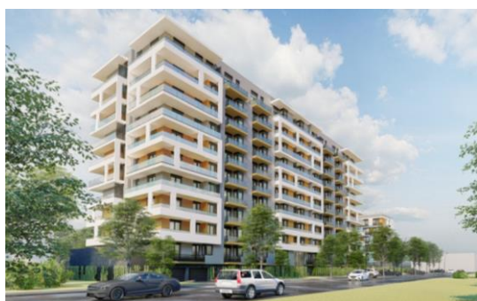
Lakóépület a Hauszmann Alajos utca felől
