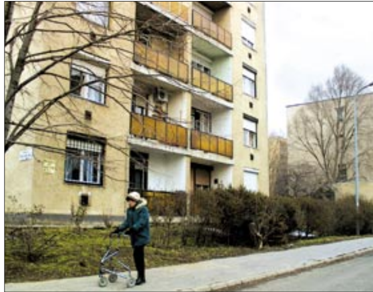
Az itt élők nem is tudják, milyen szigetelőanyagot használtak az építők
