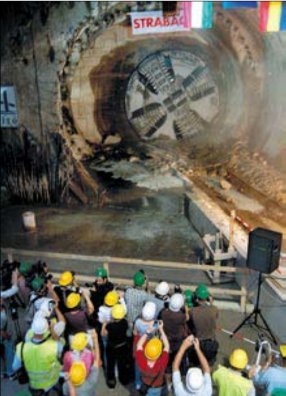
A fúrópajzs áttöri a Fővám téri állomás falát
