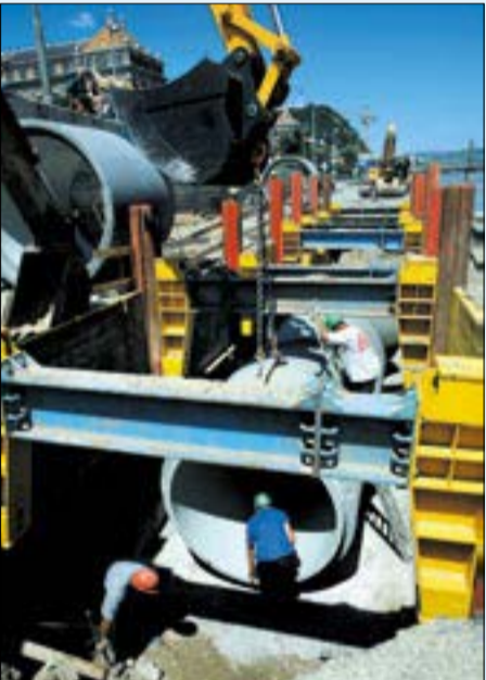
A Duna-parti szennyvízcsatorna építése a Petőfi hídnál
