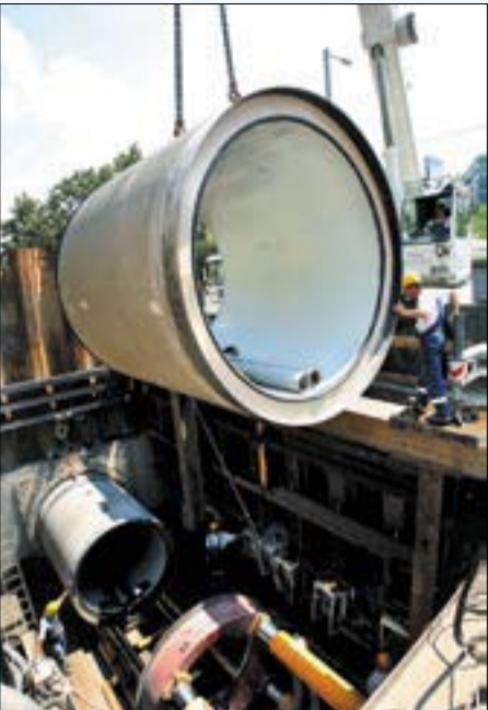
Hatalmas csőelemekből készült a főgyűjtőcsatorna az Irinyi József utcánál
