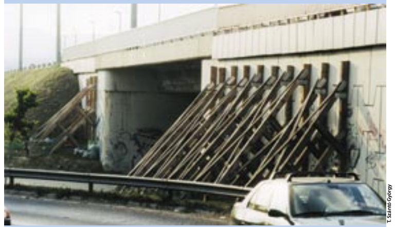
Megsérült a Lágymányosi híd felhajtójának egyik támfala a pesti oldal északi részén. A műszaki hibás támfalat ideiglenesen megtámasztották. A járda egy részén korlátozás van, de a többi szakasz alkalmas a gyalogos közlekedésre.
