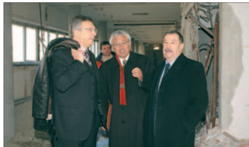
...a lentebbi szinteken még folynak az építési és felújítási munkálatok
